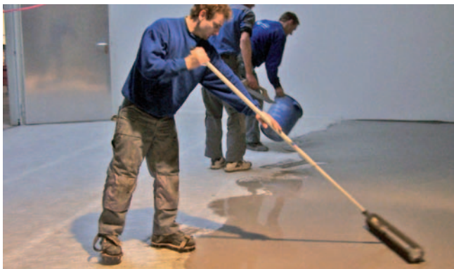
Работа с нивелирующей массой UZIN NC 170 LevelStar по свободно лежащей подложке UZIN RR 201
